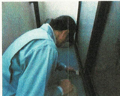
「外部（バルコニー）」調査の様子
