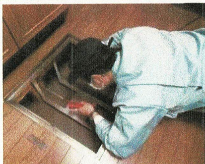
「土台・床組、基礎」調査の様子
